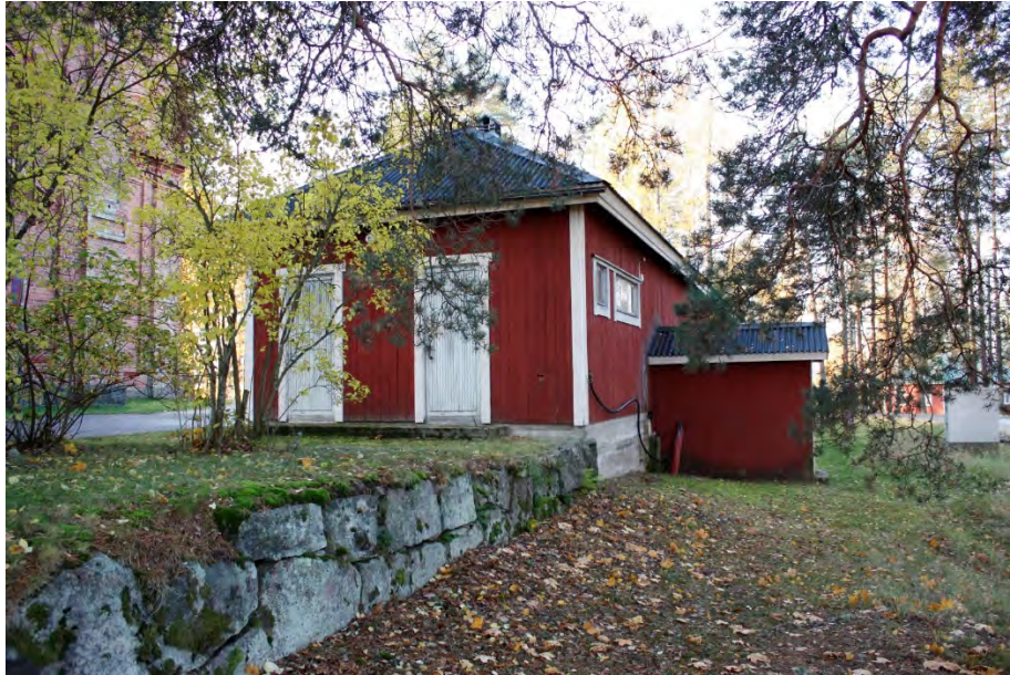
Kuva 12 – Kattilahuone kirkon pohjoispuolella toimii nykyisin varastona. Vesimittari ja sähkön pääliittymä ovat rakennuksessa.
